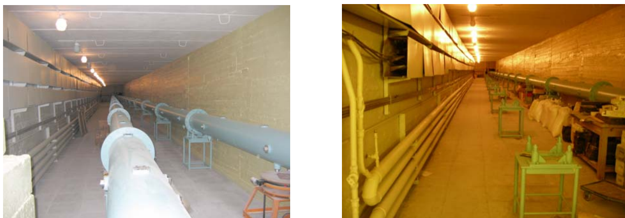
Рис. 10. Галерея вывода пучков 7 канала ИБР-2 до и после демонтажа
