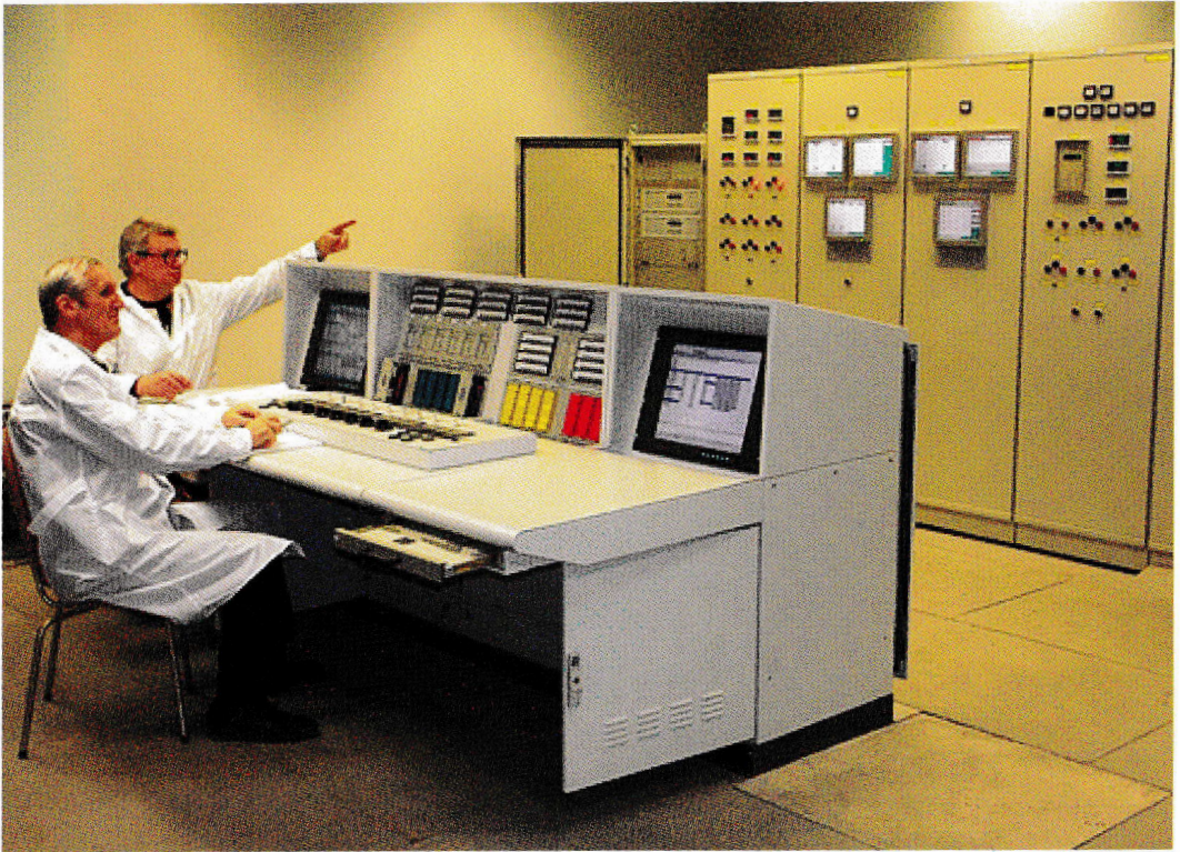
Новый пульт управления реактора ИРВ-М2
