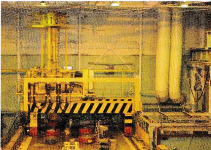
Центральный зал ИР БОР-60 (машина для перегрузки ТВС)
